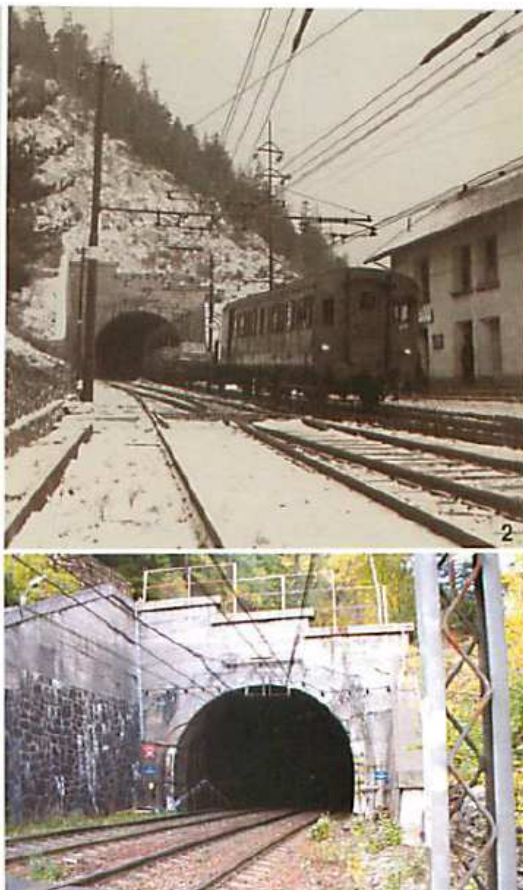
2- Entrée du tunnel début du XX e siècle. 3- Entrée du tunnel aujourd'hui.
